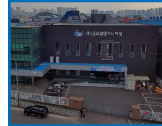
▲ 제2공장/모터,리졸버 경기 화성시 동탄산단 5길 면적: 대지 (778평) 건축 (538평)
