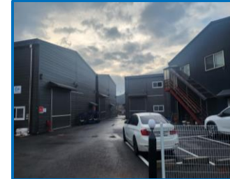
▲ 제3공장/PE모듈 용인시 남사읍 봉명리 707 면적: 대지 (600평) 건축 (160평)
